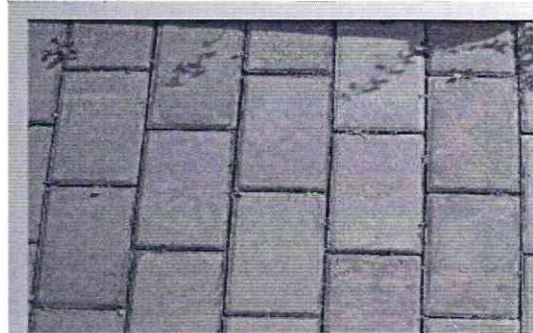
Рис. Желто-коричневые пятна, проявившиеся после укладки
